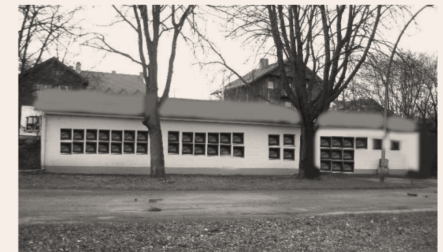
Foresti's Vision einer kleinen Museumshalle (alte Toilettenanlage in den Seeanlagen in Dießen, welche jedoch abgerissen wurden)
